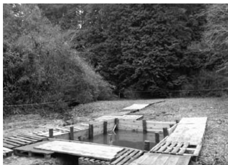
完成直後のビオトープ 周囲の板は廃材 平成22年12月
