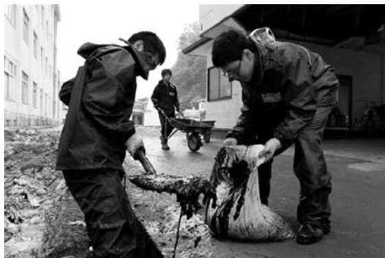
避難所横の側溝の泥出し
